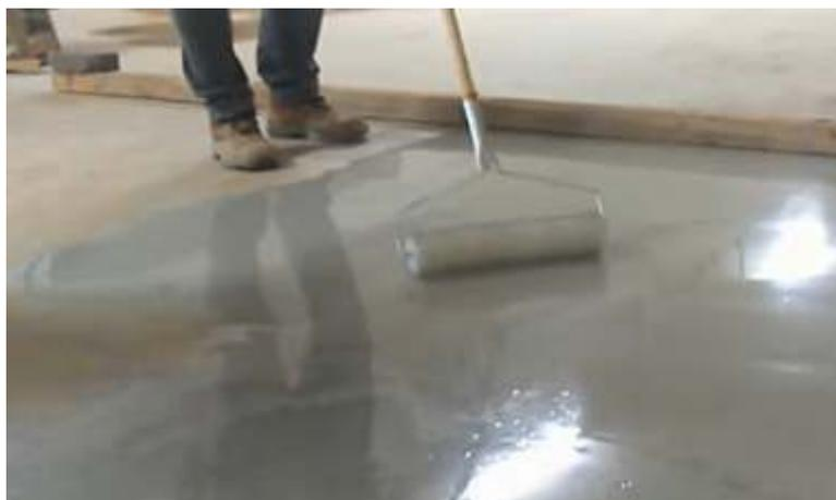
Deve utilizar argamassas de auto-nivelamento, quando necessário, para garantir o adequado nivelamento do sub-pavimento e conseqüente ausência de irregularidades na superfície do pavimento final.
